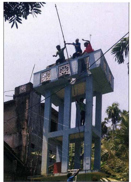
Aufbau eines Spider-Beams auf einem Wasserturm Foto: DK1AX
